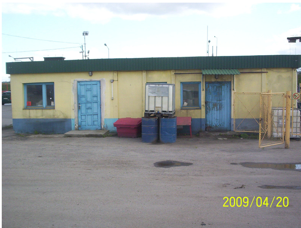
fot. 1 Elewacja frontowa budynku socjalnego stacji i magazynu podręcznego
