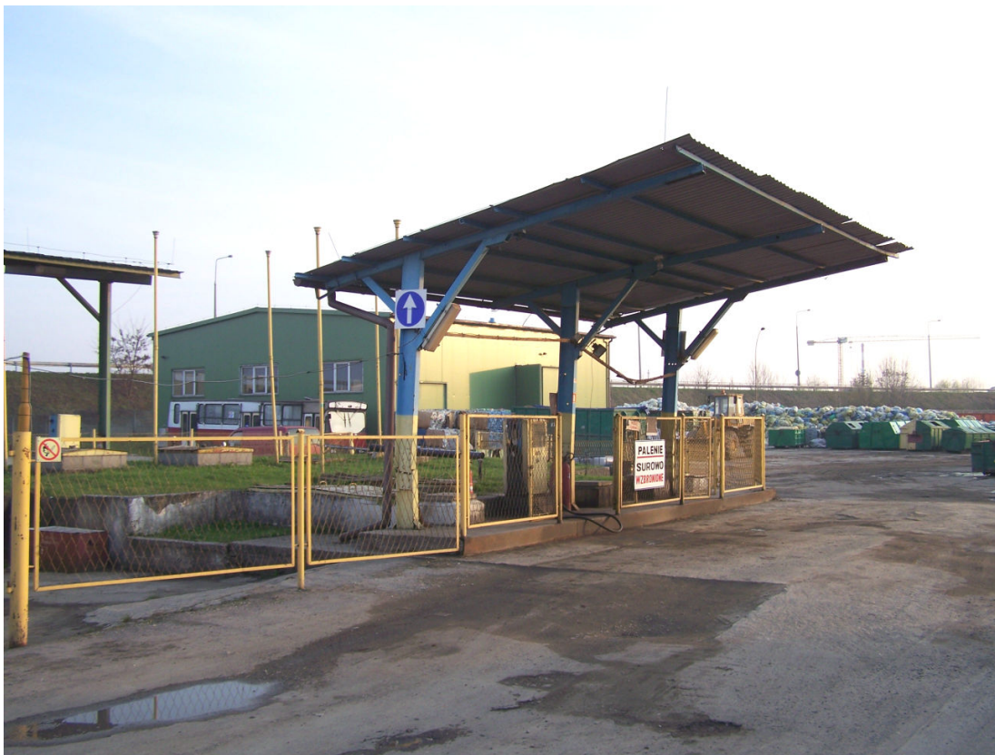
fot. 5 Zadaszenie rampy północnej
