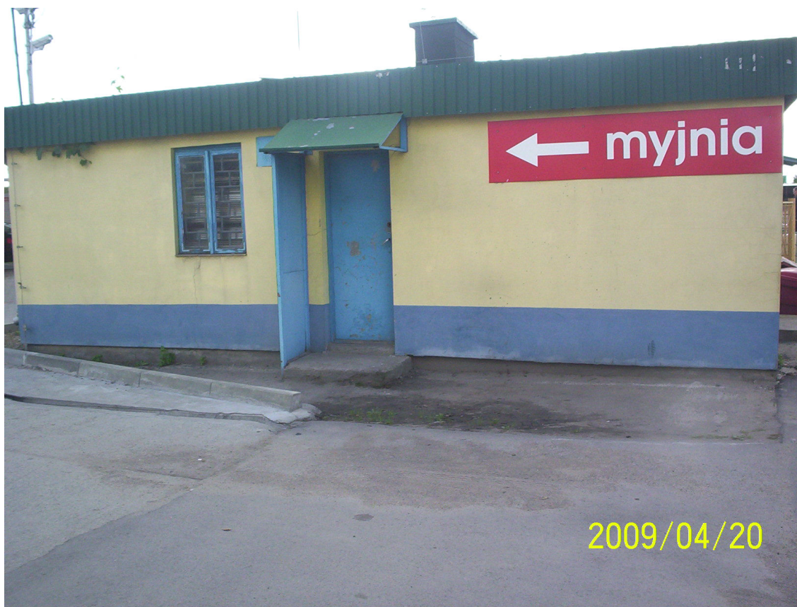
fot. 3 Elewacja boczna budynku socjalnego stacji i magazynu podręcznego
