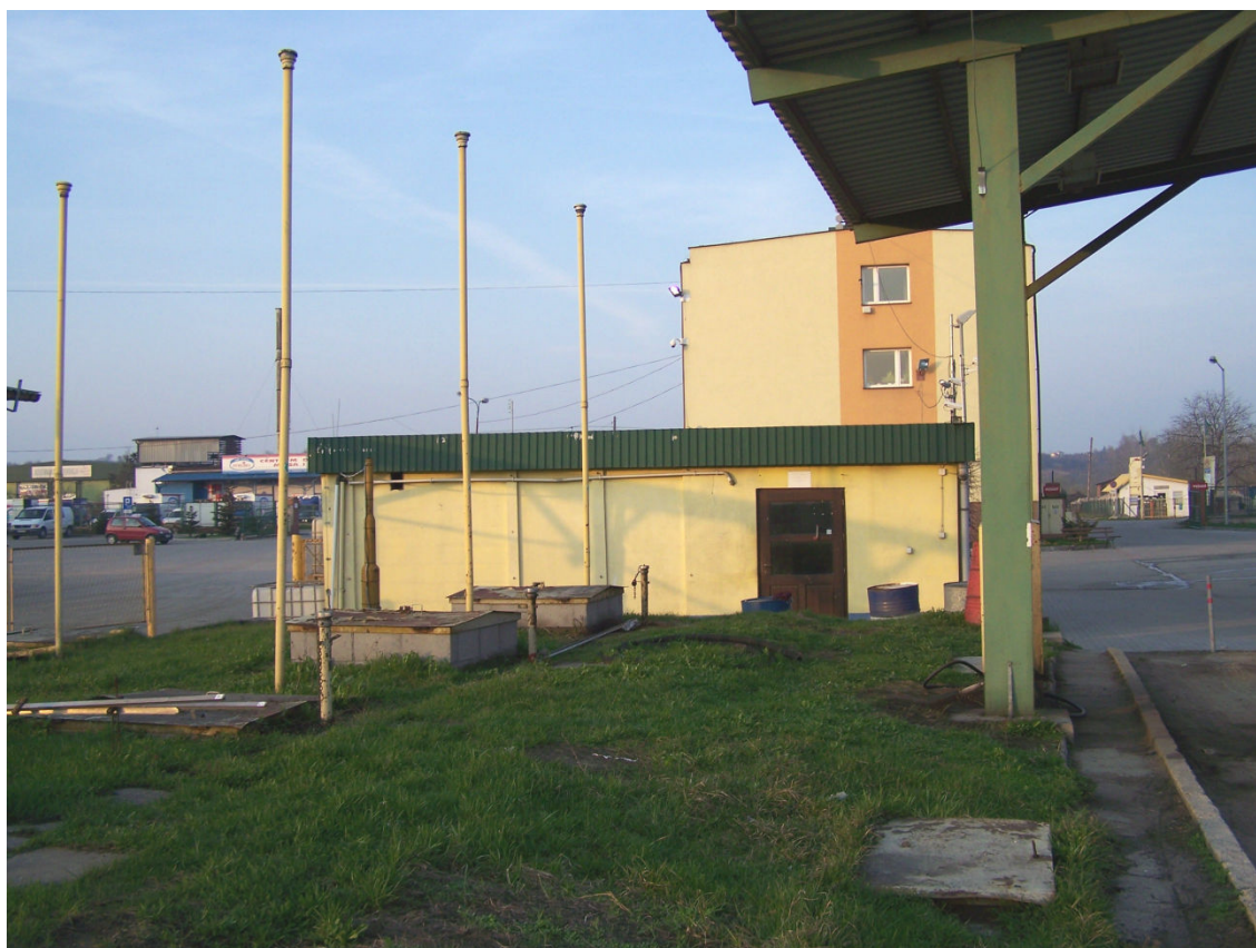
fot. 4 Elewacja boczna budynku socjalnego stacji i magazynu podręcznego
