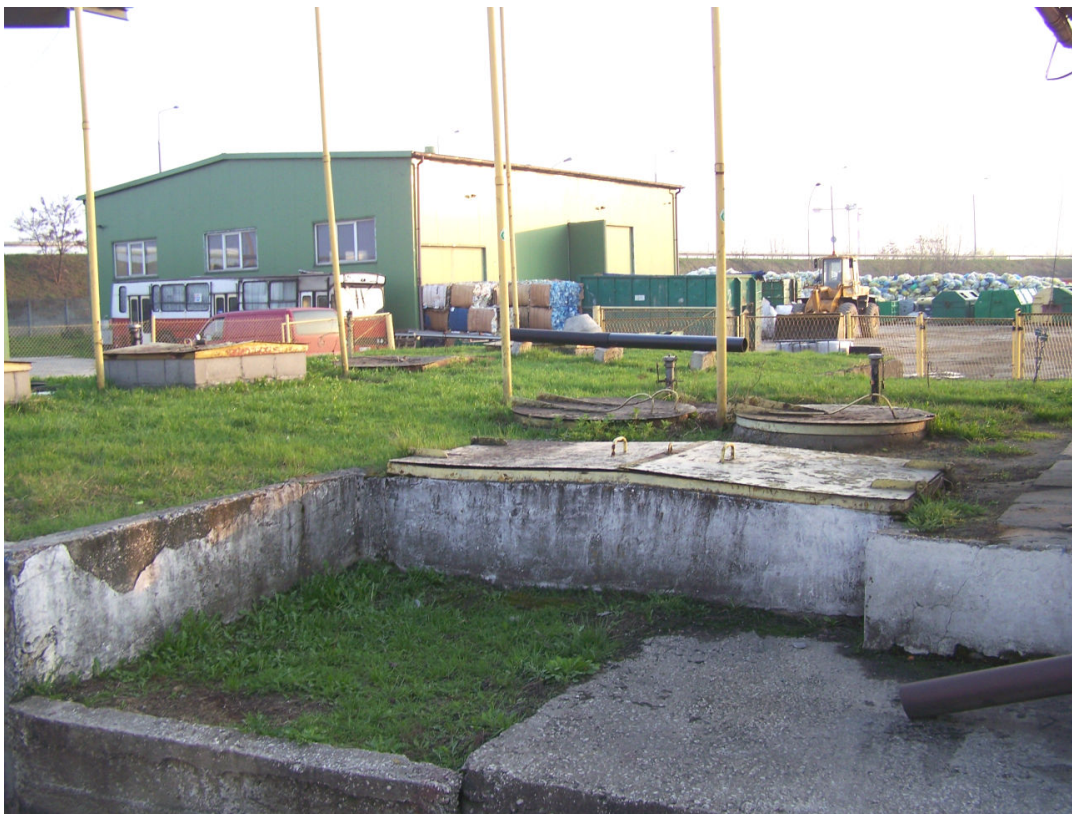
fot. 7 Zbiorniki na paliwa 5 m 3 widok od strony północnej
