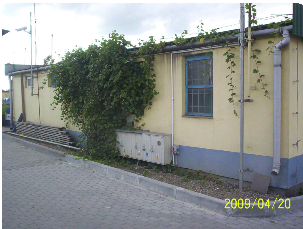
fot. 2 Elewacja tylna budynku socjalnego stacji i magazynu podręcznego
