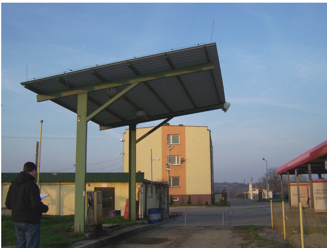
fot. 6 Zadaszenie rampy południowej
