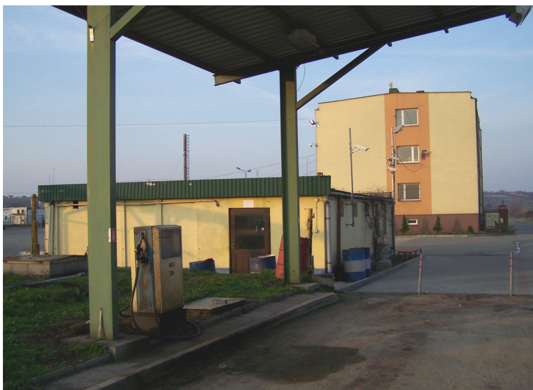
fot. 10 Rampa południowa – widok
