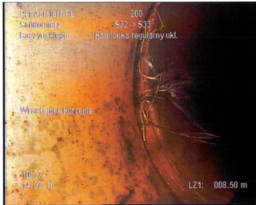
Zdjęcie: 25_8A 8,5m, Wrastające korzenie
