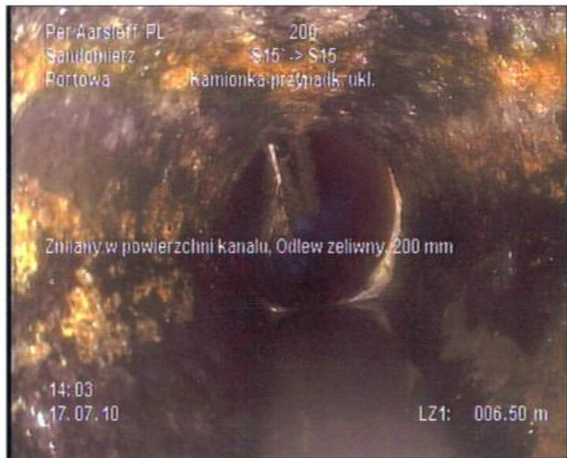
Zdjęcie: 14_3A 6,5m, Zmiany w powierzchni kanału, Odlew żeliwny, 200 mm
