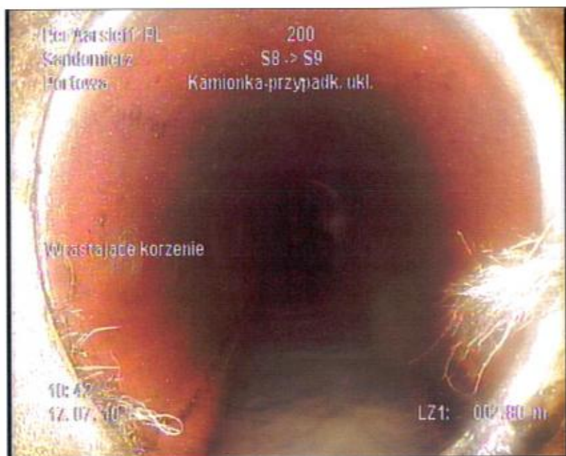
Zdjęcie: 7_2A 2,8m, Wrastające korzenie
