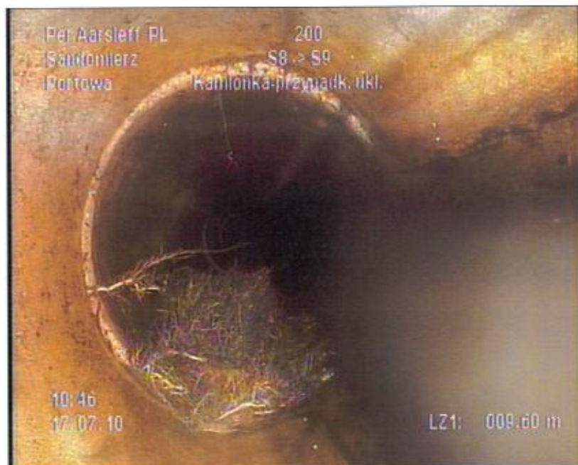
Zdjęcie: 7_7A 9,6m, Wrastające korzenie
