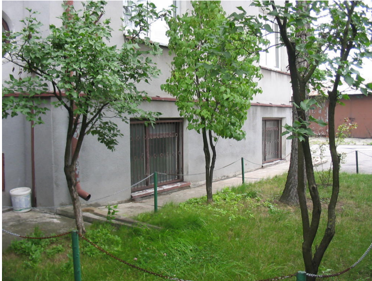
Elewacja frontowa, okna w podpiwniczeniu
