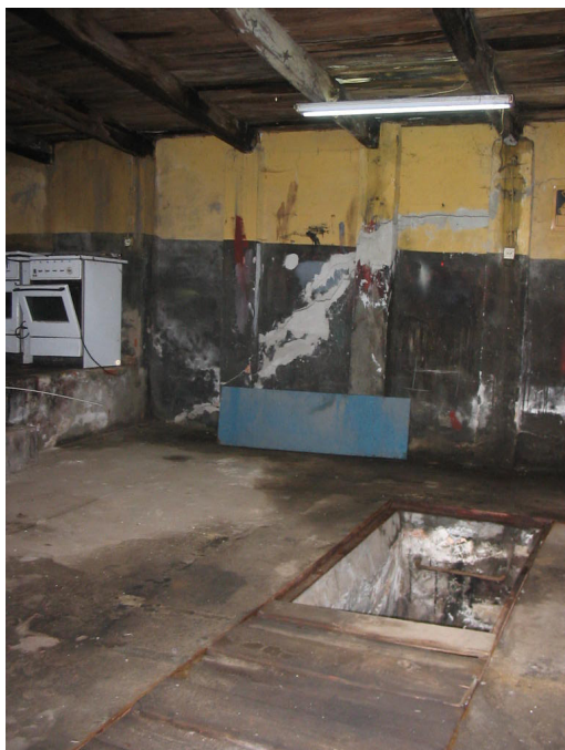
Wnętrze budynku garażowego
