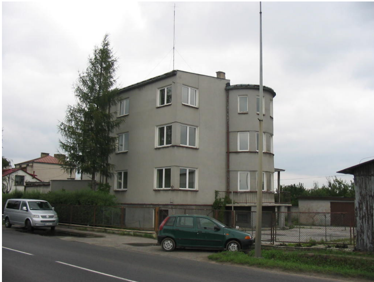
Widok nieruchomości od ulicy Elewacja frontowa i wschodnia
