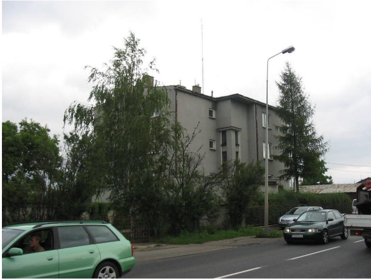
Widok nieruchomości od ulicy Elewacja frontowa i zachodnia
