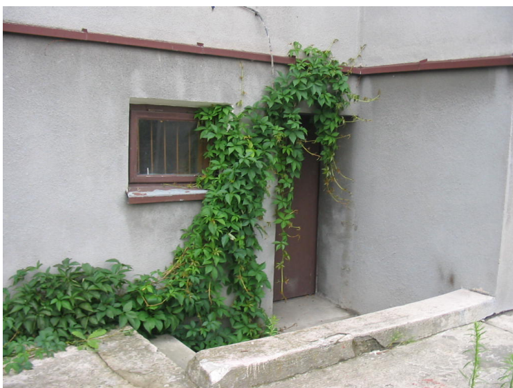
Zewnętrzne schody do piwnicy
