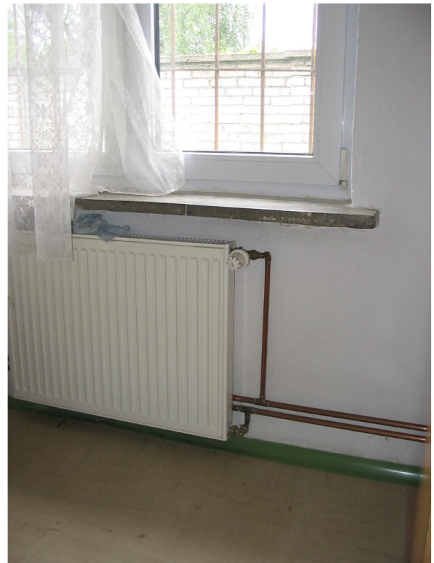
posadzka pcw, Kaloryfery purmo, okna pcw
